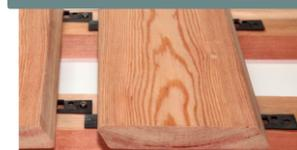
**Замковые крепежи** разработаны специально для планкена с прямым и скошенным профилем; монтаж начинается с тыльной стороны доски настила, к которой закрепляется монтажная пластина; далее доска переворачивается и видимый конец пластины заводится под тыльную сторону уже закрепленной к лаге предыдущей доски; при помощи второго видимого конца пластины доска соединяется с лаговой конструкцией; крепеж и доска создают «замок», запирающий последующую доску.
