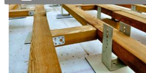
**Опорно-лаговые** крепежи разработаны для монтажа несущих конструкций:
